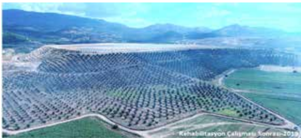
Rehabilitasyon Çalışmaları - Ovacık Altın Madeni Atık Havuzu
