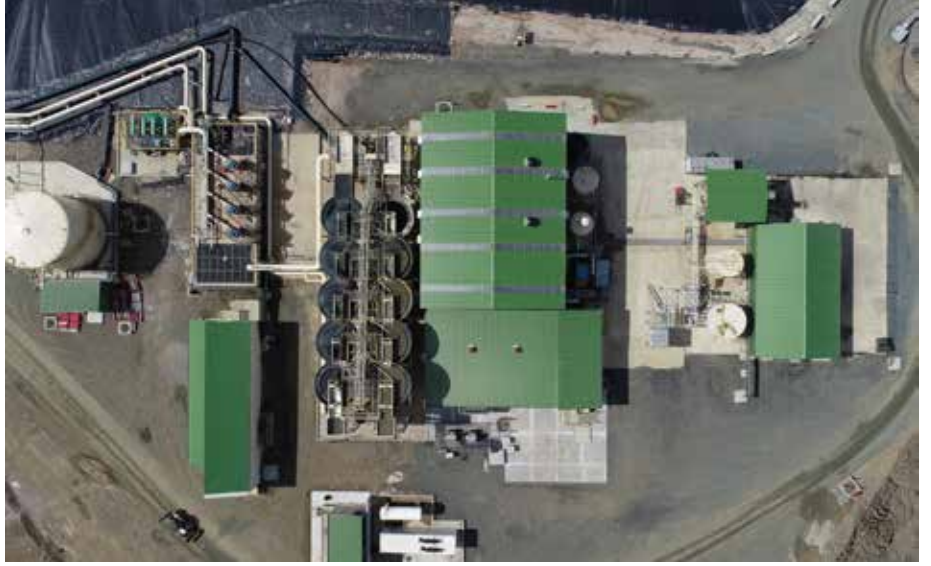
Şekil 9 - ADR Tesisi Nihai Genel Görünüm
