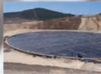
Tank Altı Uygulaması / Tüpraş/İzmir
