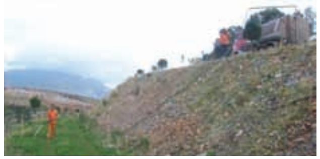
Resim 1: Kesme patlatması sonrası sulama
