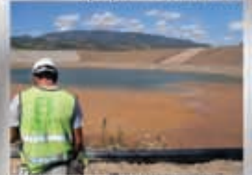
Maden Atık Depolama Tesisi / Koca Altın / Bergama
