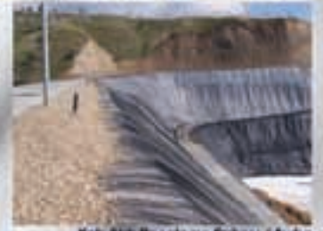
Katı Atık Depolama Sahası / Aydın
