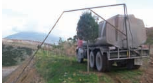
Resim 2: Kesme patlatması sonrası sulama
