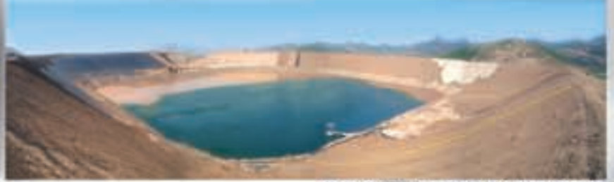
Maden Atık Depolama Tesisi / Koca Altın / Bergama
