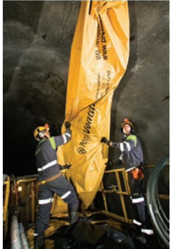
Protan Ventiflex'in Montajı
